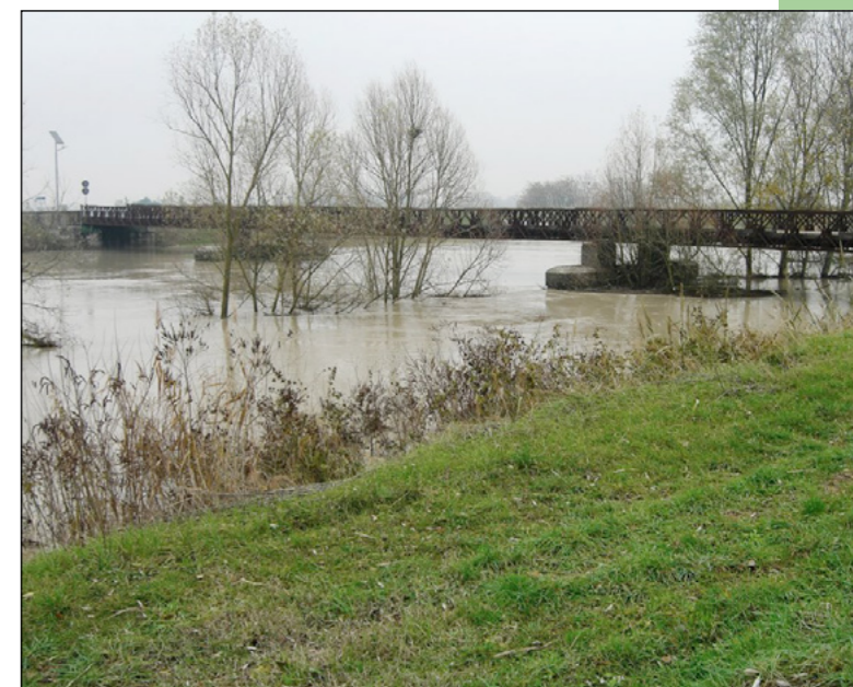
Reno in piena - ponte Bailey:
